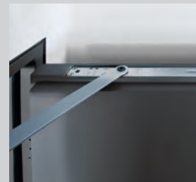
Türschließer nur von innen sichtbar
