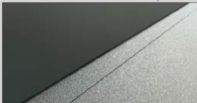
Detail Applikation und 5mm Nut waagr. Durch eine abgrenzende Nut von 10mm zwischen den beiden Blechen, wird die Applikation besonders hervorgehoben.
