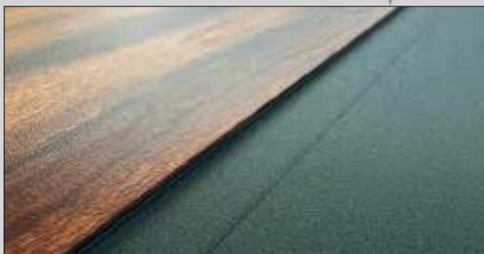
Detail aufgesetzte Applikation. Durch eine abgrenzende Nut von 10mm zwischen den beiden Blechen, wird die Applikation besonders hervorgehoben.
